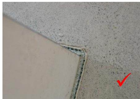
Toll ausgebildete Ecke. So muss es sein!
