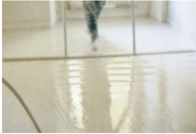
Eingiessen des Mörtels
