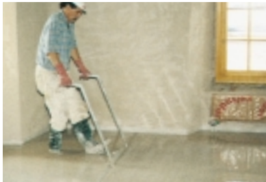
Durch leichtes Vibrieren wird der Mörtel einnivelliert
